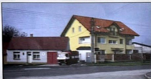
Požiarňa zbrojnica po rekonštrukcii, vpravo bytový dom
